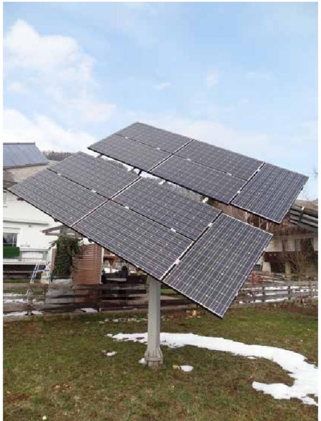
Slika 5: Sončna elektrarna Anderle z enosnim sledenjem v Selu pri Žirovnici (foto: Anja Šmit).
