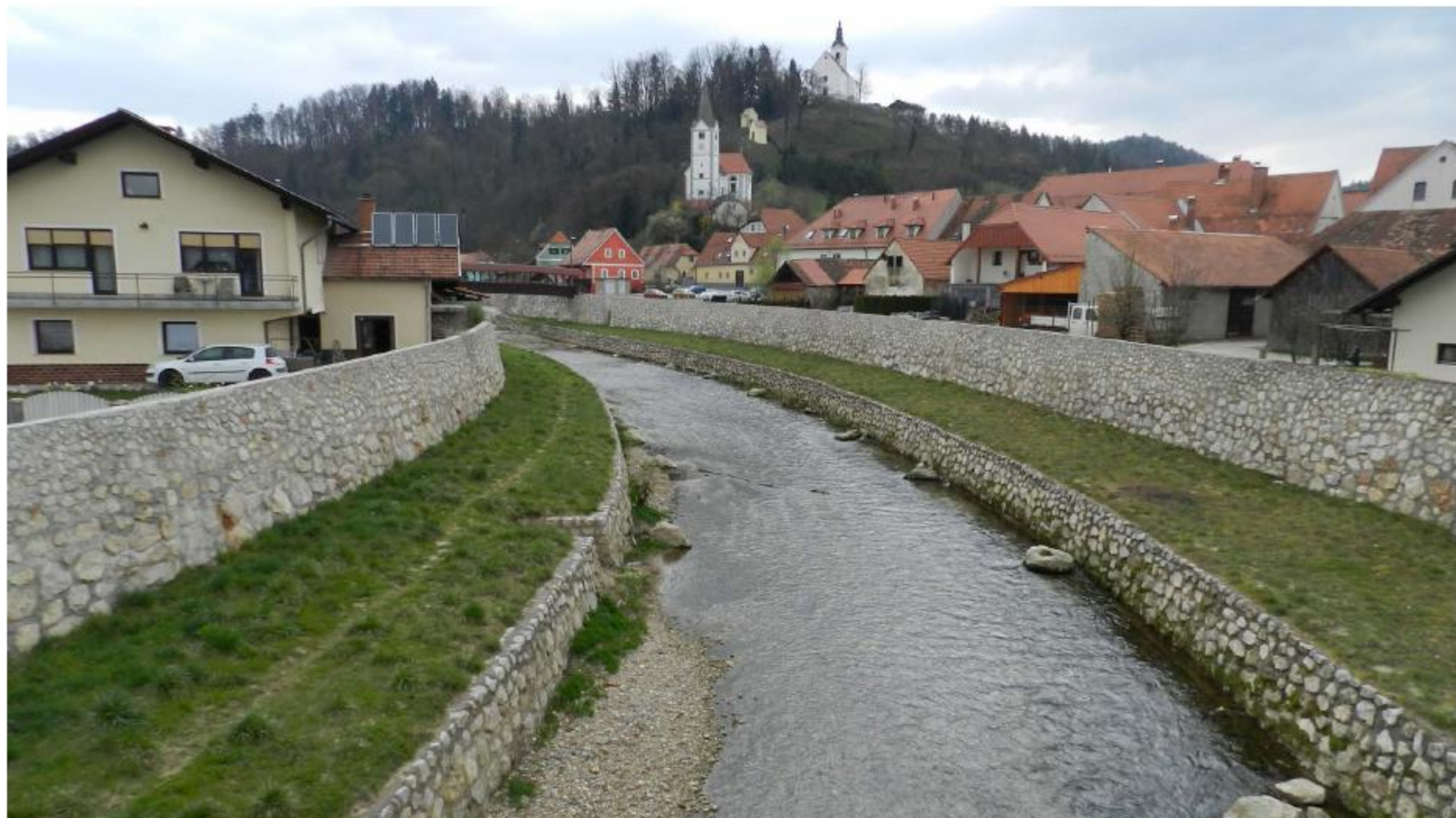
Slika 4: Protipoplavni zid v Vojniku (foto: Veronika Strmšek, 2014).
