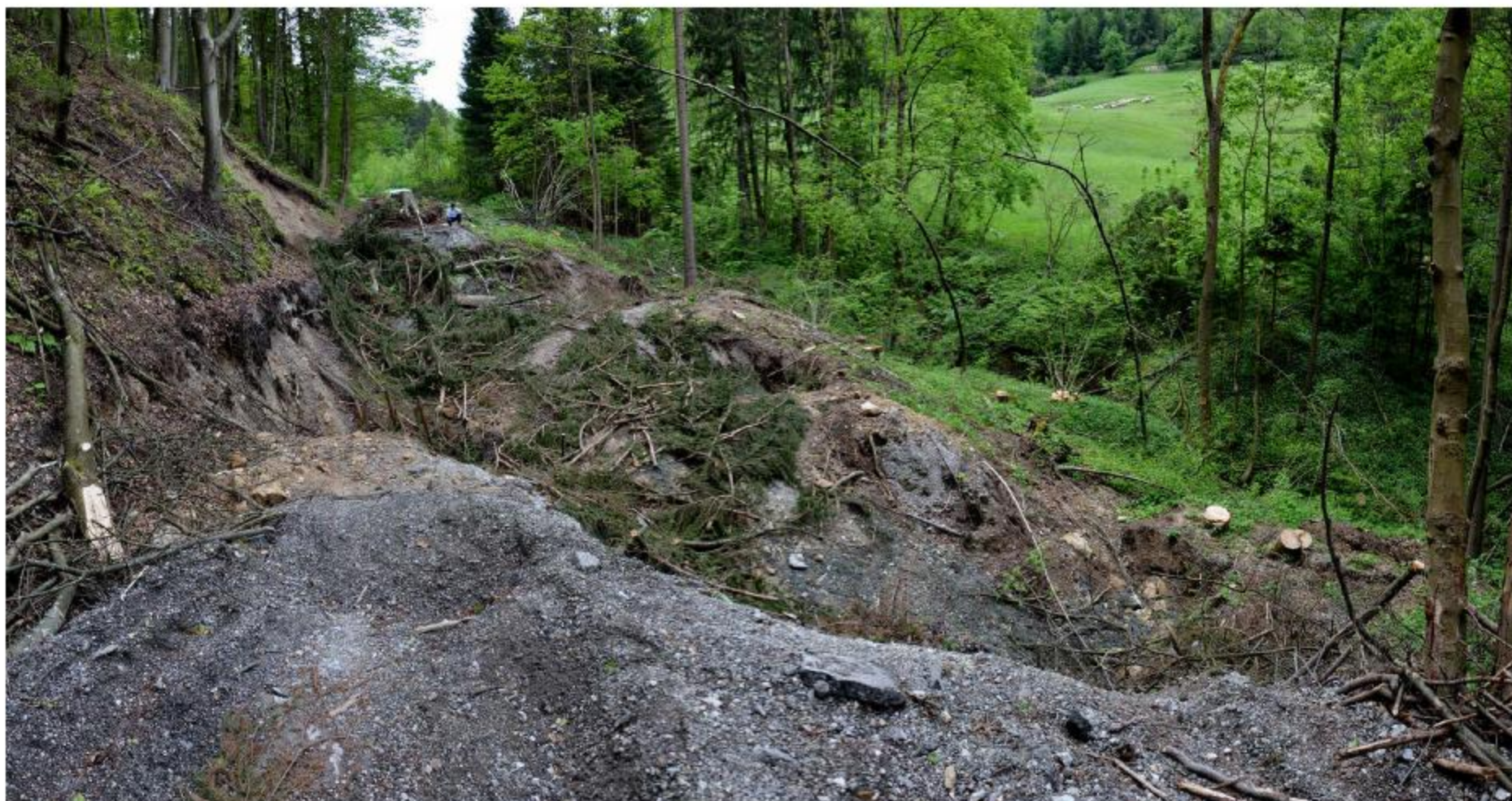
Slika 5: Zemeljski plaz na območju Raven pri Mlinšah, ki je podrl cesto (foto: Lena Kropivšek).
