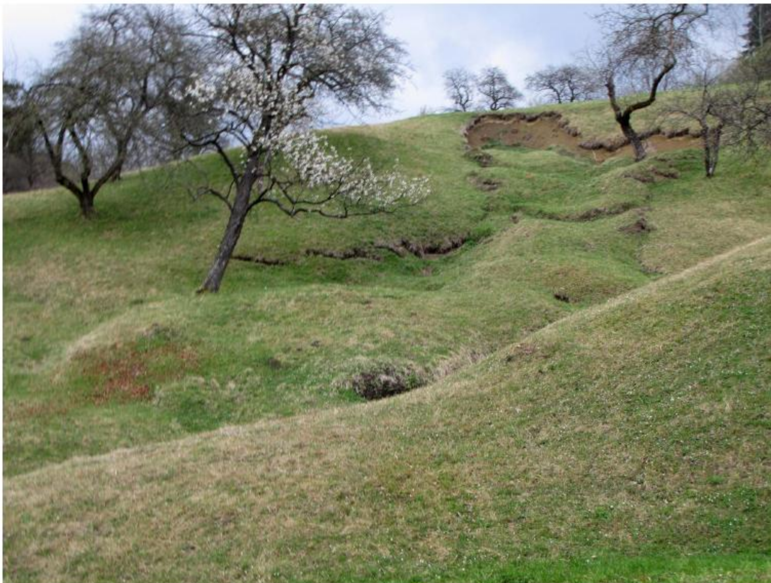
Slika 1: Zemeljski plaz na območju Plazin 1 (foto: Lena Kropivšek).
