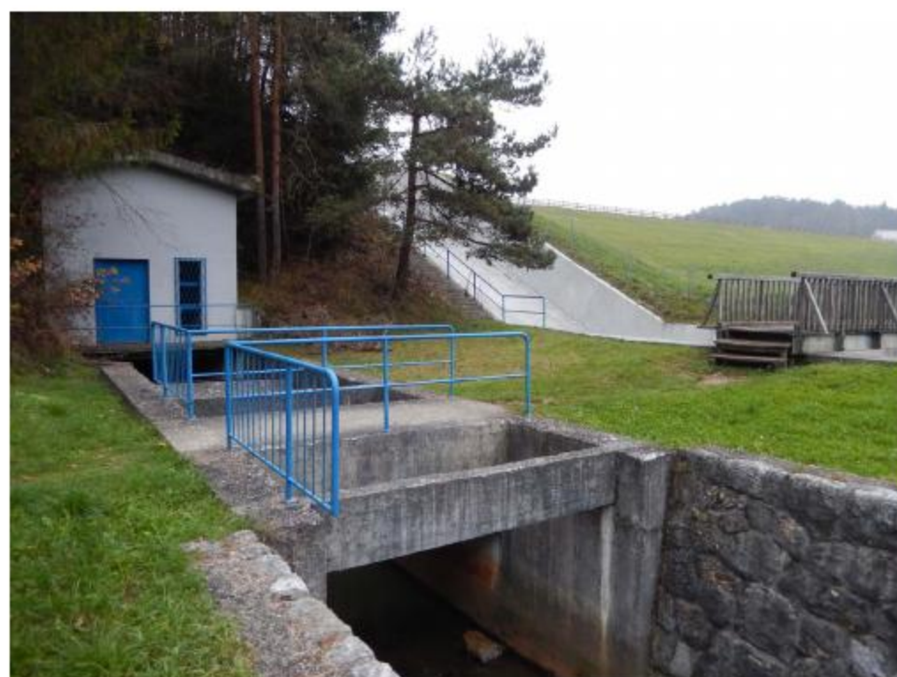
Slika 1: Sistem pregrade in zapornic Loče na Šmartinskem jezeru pri iztoku Koprivnice proti Ostrožnem (foto: A. Jelen, 2014).
